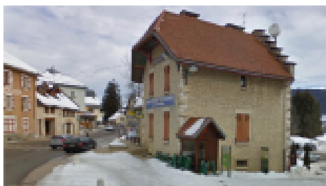
Pente du toit forte
