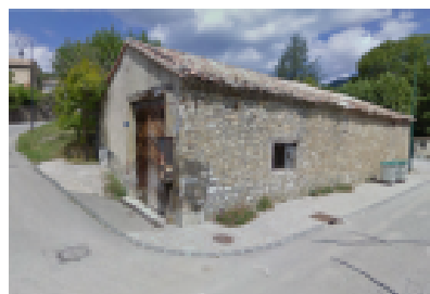
Pente du toit faible
