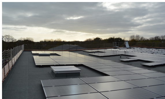
Exemple en toit terrasse sur plots thermosoudés
